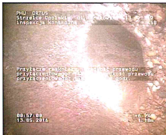
Zdjęcie: 12_2A, MPEG #: 080516_1, 00:00:40 1,18m, Przyłącze zamknięte, Wysokość przewodu przyłączeniowego: 150 mm, Szerokość przewodu przyłączeniowego: 150 mm, na 2 godz.
