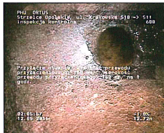
Zdjęcie: 12_5A, MPEG #: 080516_1, 00:03:26 12,7m, Przyłącze otwarte, Wysokość przewodu przyłączeniowego: 150 mm, Szerokość przewodu przyłączeniowego: 150 mm, na 1 godz.
