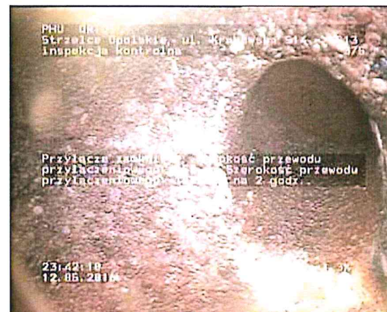
Zdjęcie: 13_5A, MPEG #: 080516_1, 00:03:13 11,42m, Przyłącze zamknięte, Wysokość przewodu przyłączeniowego: 150 mm, Szerokość przewodu przyłączeniowego: 150 mm, na 2 godz.
