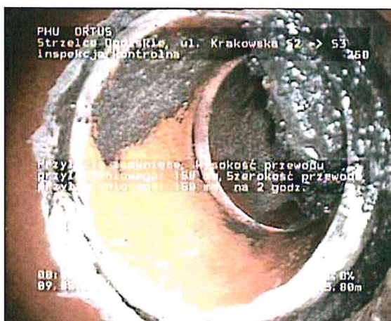
Zdjęcie: 3_4A, MPEG #: 080516_1 33,8m, Przyłącze zamknięte, Wysokość przewodu przyłączeniowego: 150 mm, Szerokość przewodu przyłączeniowego: 150 mm, na 2 godz.
