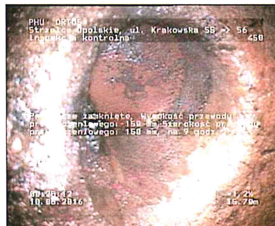
Zdjęcie: 6_3A, MPEG #: 080516_1, 00:04:40 15,7m, Przyłącze zamknięte, Wysokość przewodu przyłączeniowego: 150 mm, Szerokość przewodu przyłączeniowego: 150 mm, na 9 godz.
