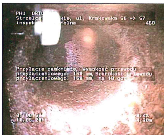
Zdjęcie: 7_4A, MPEG #: 080516_1, 00:01:58 4,2m, Przyłącze zamknięte, Wysokość przewodu przyłączeniowego: 150 mm, Szerokość przewodu przyłączeniowego: 150 mm, na 10 godz.
