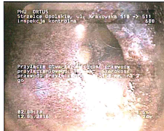
Zdjęcie: 12_7A, MPEG #: 080516_1, 00:05:13 25,24m, Przyłącze otwarte, Wysokość przewodu przyłączeniowego: 150 mm, Szerokość przewodu przyłączeniowego: 150 mm, na 2 godz.
