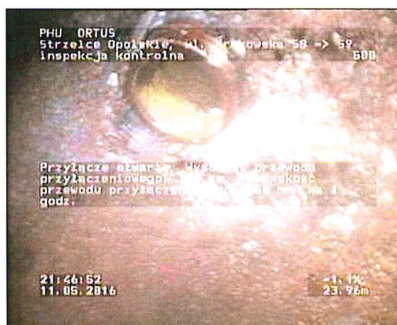
Zdjęcie: 9_8A, MPEG #: 080516_1, 00:10:31 23,96m, Przyłącze otwarte, Wysokość przewodu przyłączeniowego: 150 mm, Szerokość przewodu przyłączeniowego: 150 mm, na 1 godz.
