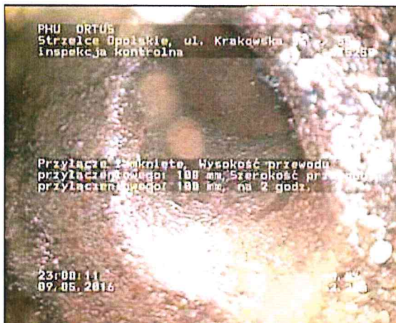
Zdjęcie: 5_8A, MPEG #: 080516_1, 00:10:33 52,28m, Przyłącze zamknięte, Wysokość przewodu przyłączeniowego: 100 mm, Szerokość przewodu przyłączeniowego: 100 mm, na 2 godz.
