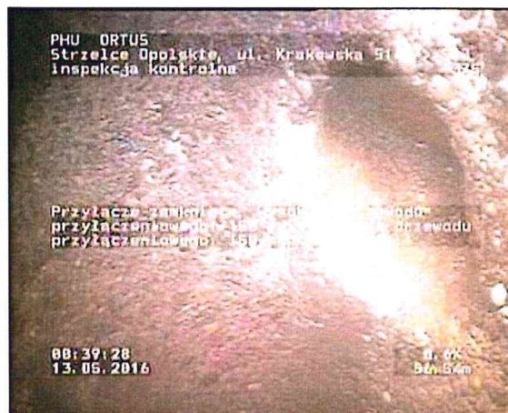
Zdjęcie: 13_18A, MPEG #: 080516_1, 00:21:35 56,54m, Przyłącze zamknięte, Wysokość przewodu przyłączeniowego: 150 mm, Szerokość przewodu przyłączeniowego: 150 mm, na 2 godz.
