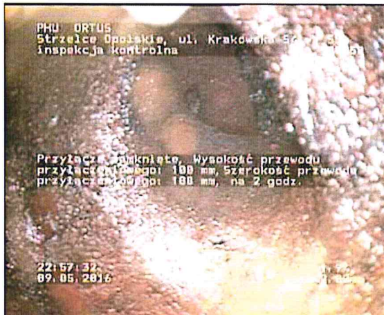
Zdjęcie: 5_6A, MPEG #: 080516_1, 00:08:28 42,02m, Przyłącze zamknięte, Wysokość przewodu przyłączeniowego: 100 mm, Szerokość przewodu przyłączeniowego: 100 mm, na 2 godz.
