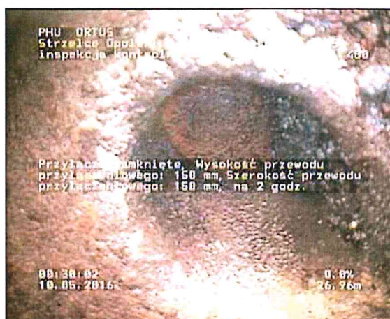
Zdjęcie: 6_8A, MPEG #: 080516_1, 00:07:50 26,94m, Przynięcie zamknięte, Wysokość przewodu przyłączeniowego: 150 mm, Szerokość przewodu przyłączeniowego: 150 mm, na 2 godz.
