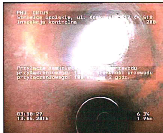
Zdjęcie: 17_3A, MPEG #: 080516_1, 00:01:03 1,96m, Przystępe zamknięte, Wysokość przewodu przyłączeniowego: 100 mm, Szerokość przewodu przyłączeniowego: 100 mm, na 2 godz.
