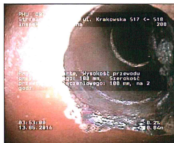
Zdjęcie: 17_5A, MPEG #: 080516_1, 00:02:55 10,84m, Przystępe otwarte, Wysokość przewodu przyłączeniowego: 100 mm, Szerokość przewodu przyłączeniowego: 100 mm, na 2 godz.
