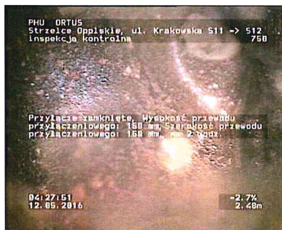
Zdjęcie: 13_5A, MPEG #: 080516_1, 00:02:02 2,48m, Przyłącze zamknięte, Wysokość przewodu przyłączeniowego: 150 mm, Szerokość przewodu przyłączeniowego: 150 mm, na 2 godz.
