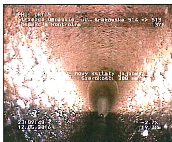
Zdjęcie: 13_9A, MPEG #: 080516_1, 00:07:50 19,38m, Zmiana kształtu, nowy kształt jajaowy, Wysokość: 450 mm, Szerokość: 300 mm
