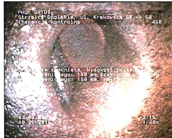
Zdjęcie: 8_3A, MPEG #: 080516_1, 00:01:17 1,48m, Przyłącze zamknięte, Wysokość przewodu przyłączeniowego: 150 mm, Szerokość przewodu przyłączeniowego: 150 mm, na 10 godz.
