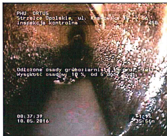
Zdjęcie: 6_10A, MPEG #: 080516_1, 00:10:03 35,56m, Odłożone osady gruboziarniste tj gruz, żwir, Wysokość osadów: 10 %, od 5 do 7 godz.
