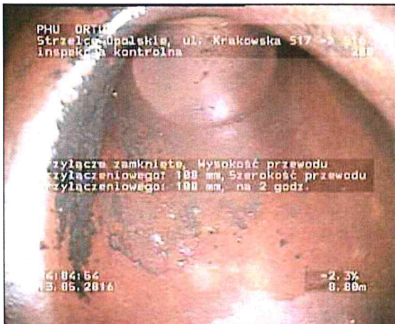
Zdjęcie: 16_2A, MPEG #: 080516_1, 00:01:17 8,8m, Przyłącze zamknięte, Wysokość przewodu przyłączeniowego: 100 mm, Szerokość przewodu przyłączeniowego: 100 mm, na 2 godz.
