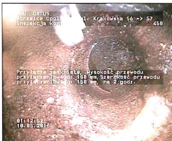
Zdjęcie: 7_8A, MPEG #: 080516_1, 00:07:34 18,4m, Przyłącze zamknięte, Wysokość przewodu przyłączeniowego: 150 mm, Szerokość przewodu przyłączeniowego: 150 mm, na 2 godz.
