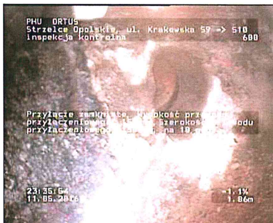
Zdjęcie: 11_2A, MPEG #: 080516_1, 00:00:38 1,84m, Przyłącze zamknięte, Wysokość przewodu przyłączeniowego: 150 mm, Szerokość przewodu przyłączeniowego: 150 mm, na 10 godz.
