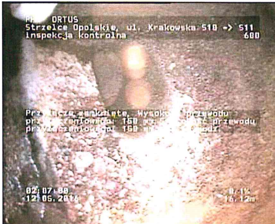
Zdjęcie: 12_6A, MPEG #: 080516_1, 00:04:09 16,12m, Przyłącze zamknięte, Wysokość przewodu przyłączeniowego: 150 mm, Szerokość przewodu przyłączeniowego: 150 mm, na 10 godz.
