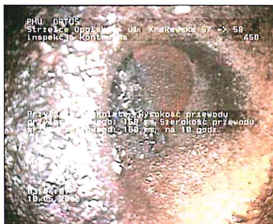
Zdjęcie: 8_4A, MPEG #: 080516_1, 00:02:19 5,58m, Przyłącze zamknięte, Wysokość przewodu przyłączeniowego: 150 mm, Szerokość przewodu przyłączeniowego: 150 mm, na 10 godz.
