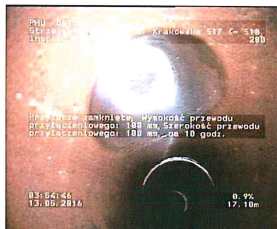
Zdjęcie: 17_7A, MPEG #: 080516_1, 00:04:09 17,1m, Przyłącze zamknięte, Wysokość przewodu przyłączeniowego: 100 mm, Szerokość przewodu przyłączeniowego: 100 mm, na 10 godz.
