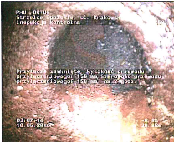
Zdjęcie: 8_6A, MPEG #: 080516_1, 00:04:50 20,88m, Przyłącze zamknięte, Wysokość przewodu przyłączeniowego: 150 mm, Szerokość przewodu przyłączeniowego: 150 mm, na 2 godz.
