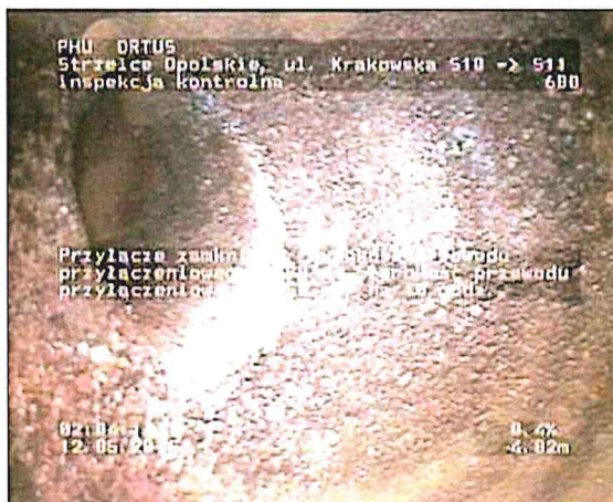
Zdjęcie: 12_4A, MPEG #: 080516_1, 00:02:01 4,82m, Przyłącze zamknięte, Wysokość przewodu przyłączeniowego: 150 mm, Szerokość przewodu przyłączeniowego: 150 mm, na 10 godz.
